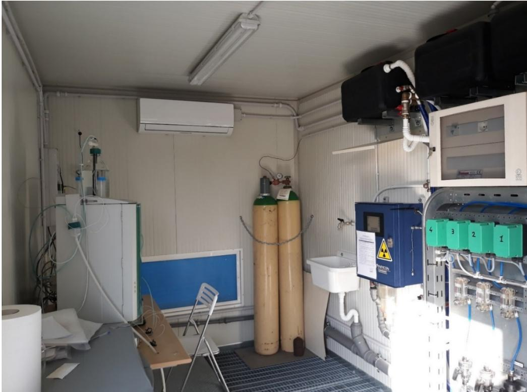
Figura 2. Esempio di una installazione sul campo in container di sensori per la analisi di Disinfection By Products (DBP) in acque potabilizzate
