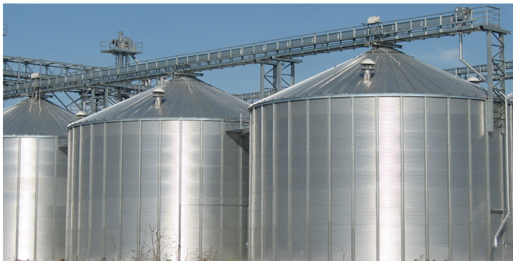
Figura 5. Silos di stoccaggio verticali
