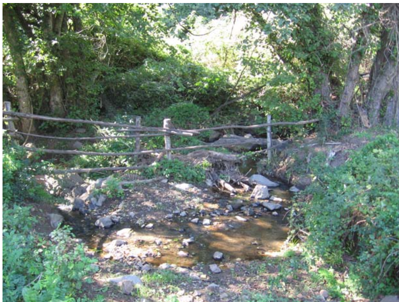
Figura 5. Fosso di Monte Sassano sito a monte
