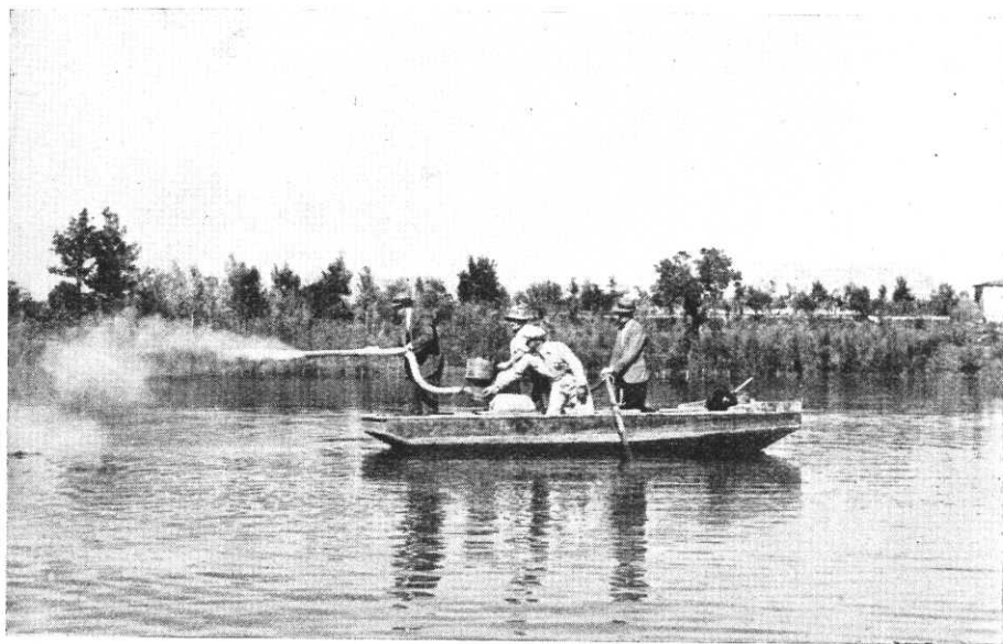
FIG. 6. - Spandimento del verde di Schweinfurt con grande ventilatore.
