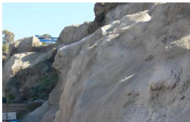
Riduzione della dispersione di polveri mediante l'applicazione di Spritz-beton
