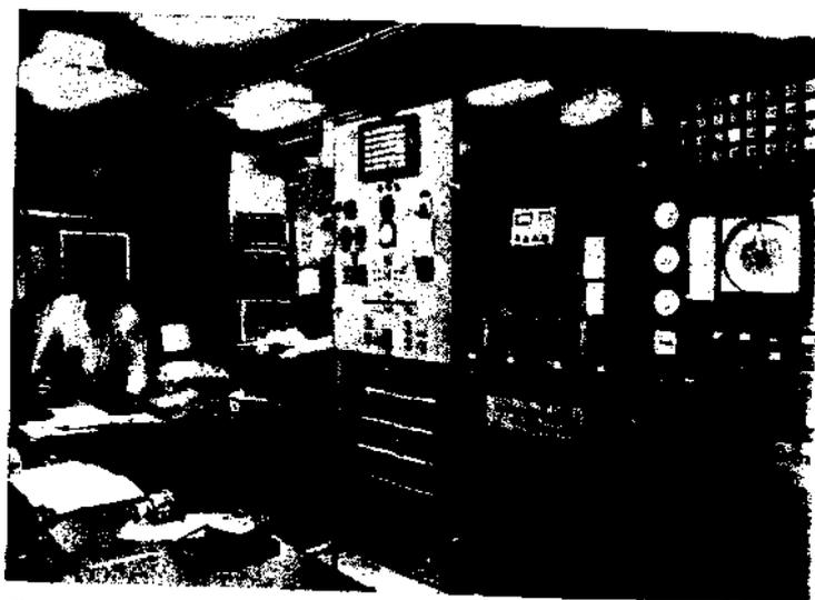
Fig. 12. — Box con un calcolatore per la registrazione dei dati ed il controllo operativo.
