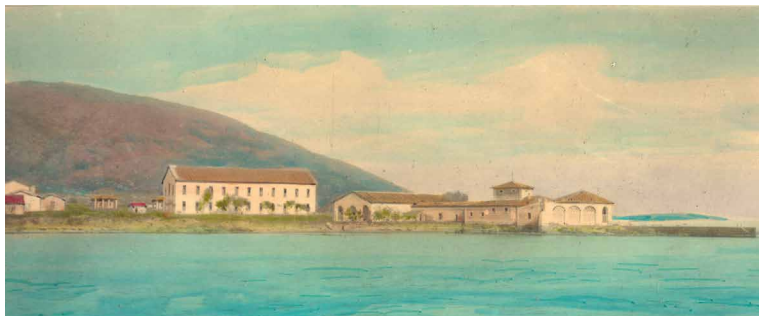
Stazione sanitaria dell'isola dell'Asinara, Cala Reale. Edificio della terza classe e stabilimento bagni e disinfezioni. Dall'album fotografico "I prigionieri di guerra austriaci all'Asinara. 18 dicembre 1915-24 luglio 1916"
