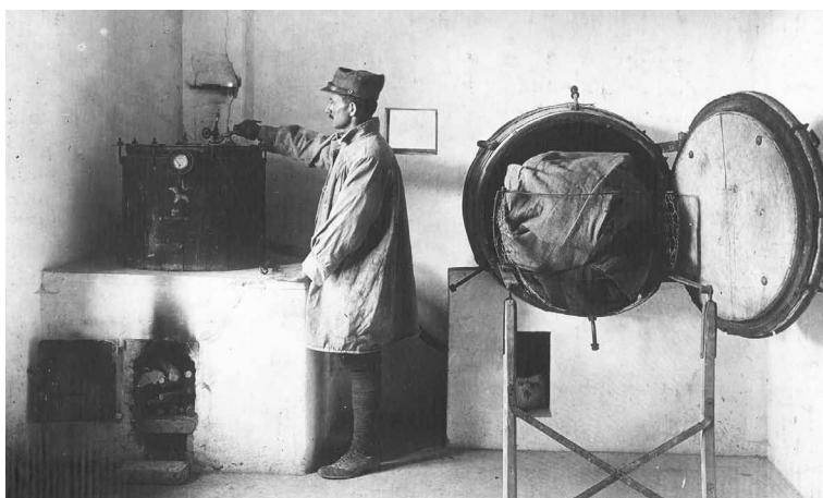
La sezione di disinfezione ha improvvisato presso la propria sede una stufa di disinfezione con mezzi di fortuna, mediante una botte, una generatrice di vapore, dei tubi ed alcuni accessori trovati. Dal libro fotografico dell'esercito italiano "I servizi di una sezione di disinfezione", agosto 1917
