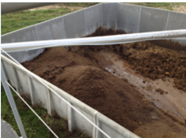
Foto 2 - Area di stoccaggio del digestato solido prodotto in un impianto per la produzione di biogas
