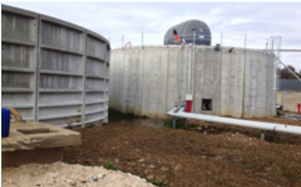
Foto 1 - Digestore di un impianto per la produzione di biogas
