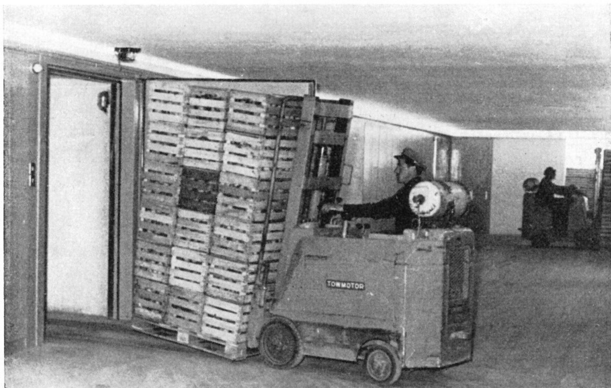
Fig. 8. - Centrale Ortofrutticola Meranese - Merano. Passando davanti all'occhio di una cellula fotoelettrica, il carrello ha provocato l'apertura automatica della porta di accesso ad una cella e si accinge ad entrare; tra qualche secondo, quando il carrello sarà già entrato, la porta si richiuderà automaticamente (per gentile concessione delle Officine Meccaniche ing. Dell'Orto di Milano).
