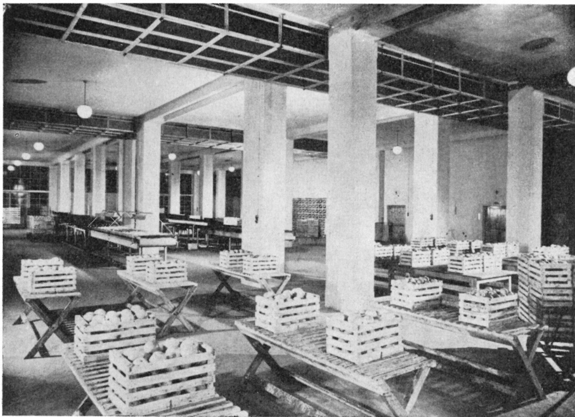
Fig. 2. - Cella confezione nella centrale ortofrutticola del Consorzio Agrario di Ferrara. Si notino le canalizzazioni per la distribuzione dell'aria condizionata (per gentile concessione della Ditta SAMIFI di Milano).
