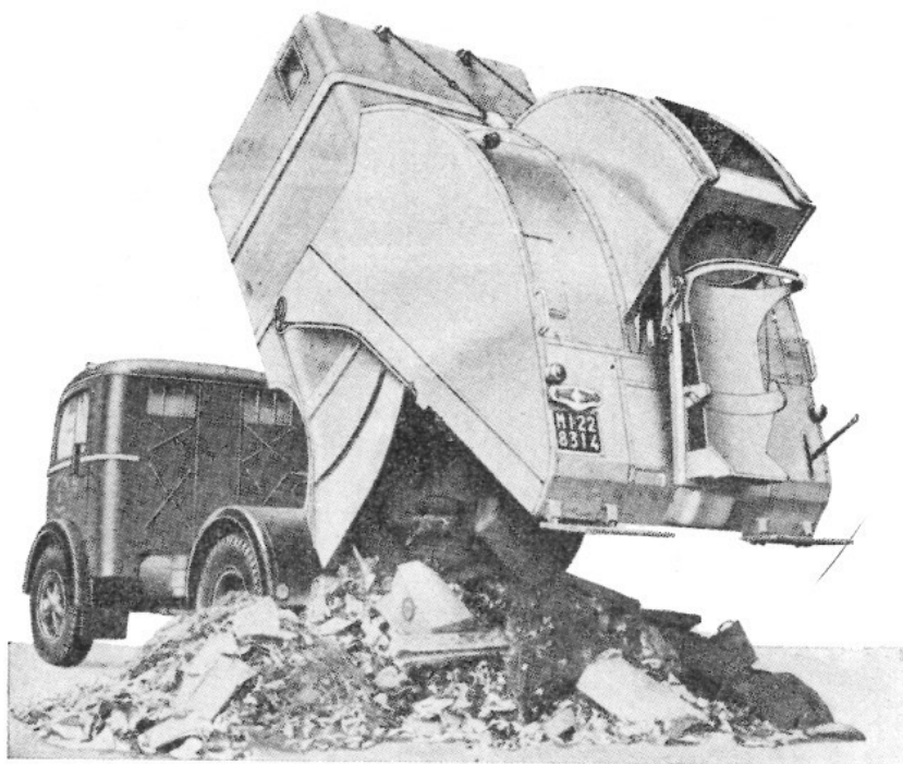
Fig. 20. - Operazione di vuotamento di un automezzo fornito di costipatore a diaframma.
