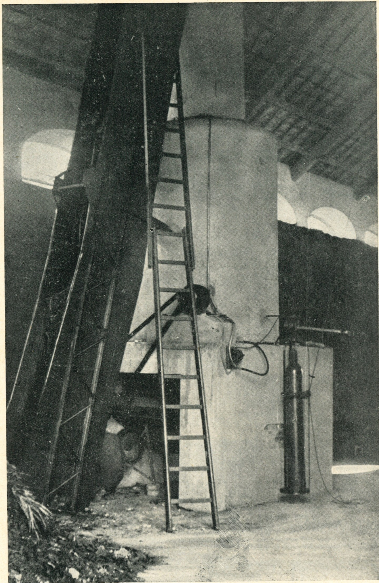
FIG. 2. - Digestore: dispositivo di carico.
