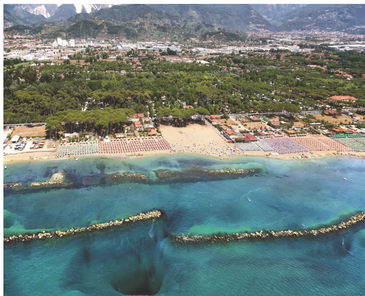
Figura 7. Marina di Massa: buca scavata dall'acqua all'uscita da un varco fra scogliere parallele (immagine con esagerazione verticale) (GeoCoste snc)
