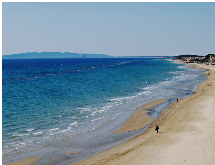
Figura 9. Scogliera parallela sommersa con soglie ribassate nel Golfo di Follonica, Se ne percepisce la presenza per il frangimento delle onde al superamento della cresta
