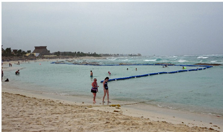
Figura 8. Chacalal, Messico: un galleggiante racchiude il tratto di mare posto dietro alle difese parallele costruite con geocontenitori in modo che i bagnanti non vengano trasportati delle correnti all'esterno delle difese o lungo riva da dove poi potrebbero essere spinti verso il largo
