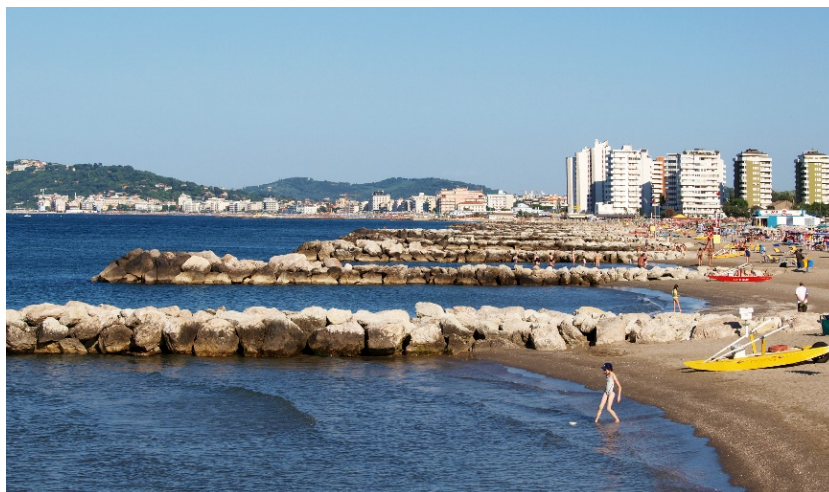
Figura 12. Misano (Emilia-Romagna): sequenza di pennelli molto ravvicinati (rapporto lunghezza/distanza prossimo ad uno)
