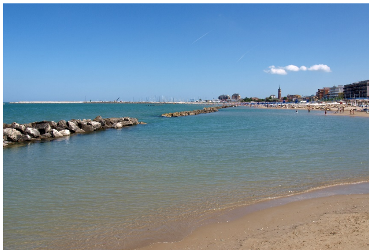
Figura 6. Scogliere parallele a Civitanova Marche, con varchi molto stretti in rapporto alla lunghezza delle singole strutture
